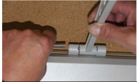
Federeingabe über die Schraube ziehen und Wandhalter und Heizstrahler verbinden
