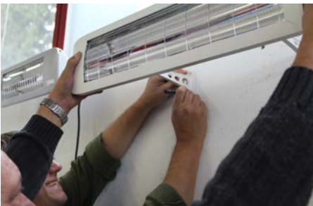
Je zwei Löcher im vorgegebenen Abstand an der Wand anzeichnen/
