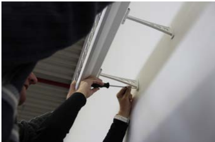
Beide Schrauben jedes Halters einschrauben und mit Schraubendreher festziehen. Eine zweite Person hält den Strahler dabei fest.
